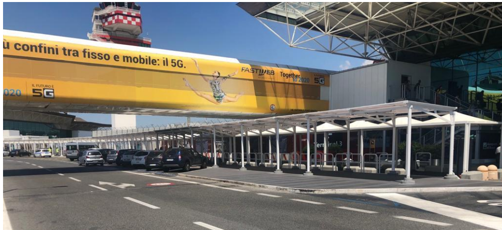
Figura 3 | FCO | Accessibilità | Nuova pensilina dedicata al flusso pedonale tra partenze T1 e T3
