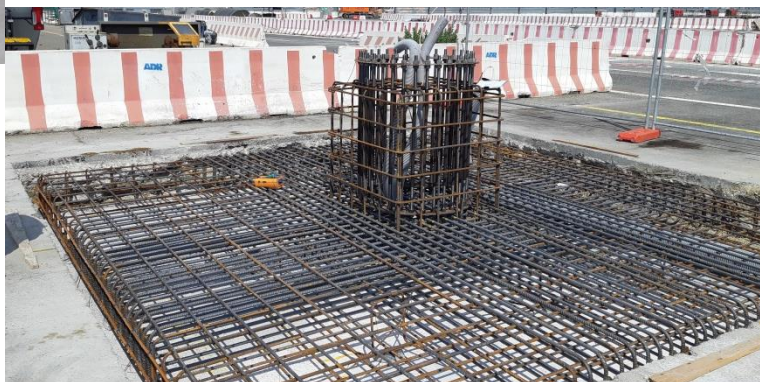
Realizzazione nuovo basamento torre faro
