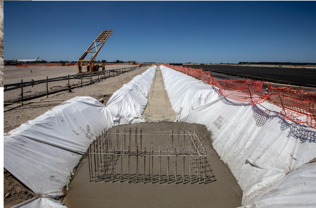
Area ovest fase 2 – Realizzazione opere idrauliche
