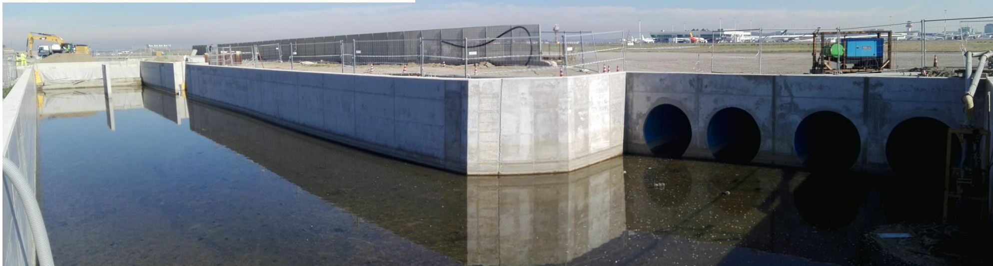
Realizzazione vasca disoleatore in c.a. Ovest RWY 16R34L
