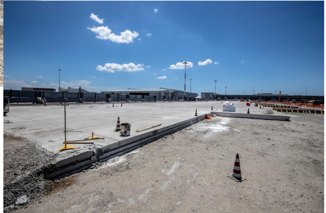
Fronte est lato area tecnica Alitalia
