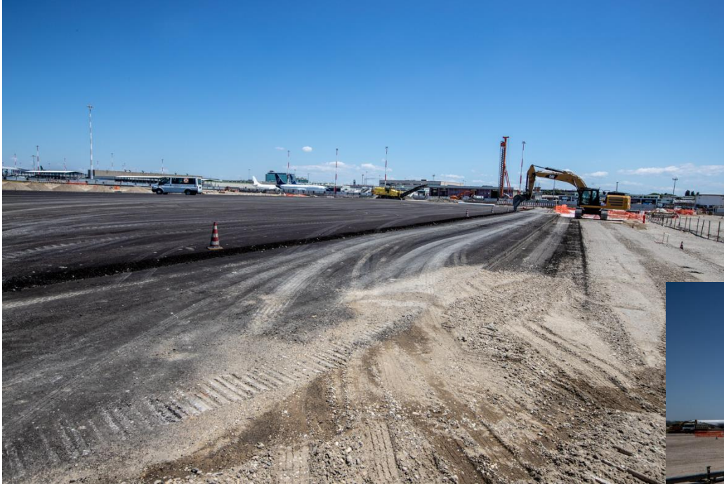
Area ovest fase 2 – Realizzazione pavimentazione flessibile
