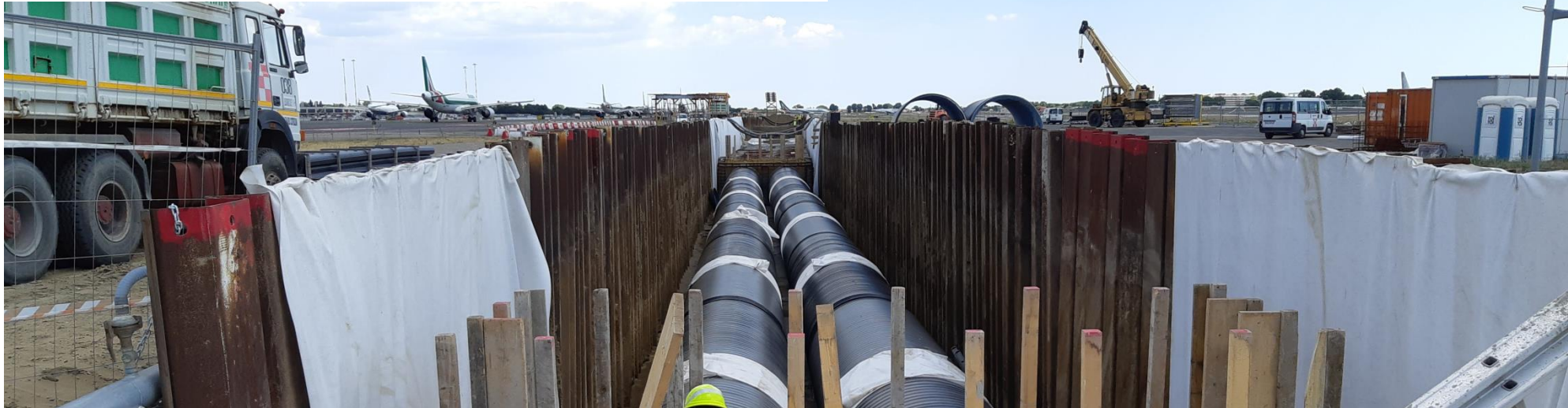
Nuovo collettore – alloggiamento collettori attraversamento Taxiway AG
