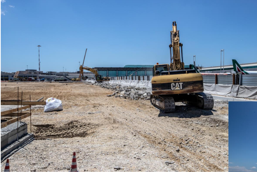
Fronte ovest lato quadrante 400
