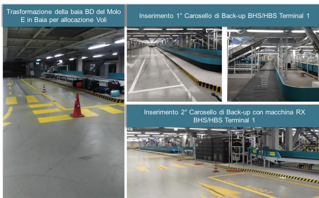
Figura 11 | FCO | INFRASTRUCTURE REVITALIZATION | Aumento della capacità ricettiva in ambito bagagli
